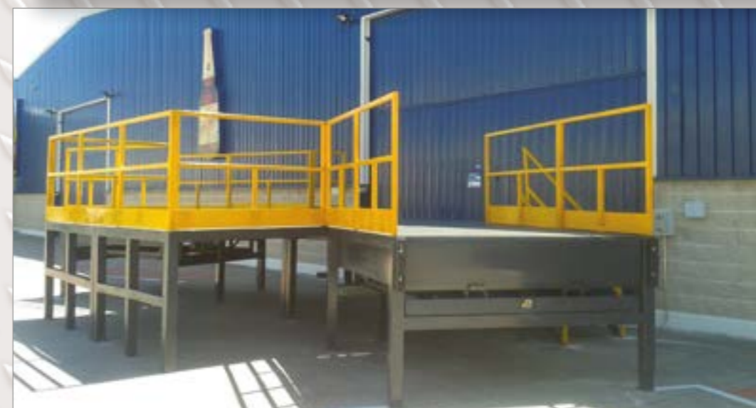
Bancadas simple pasillo con zona de maniobrabilidad.
