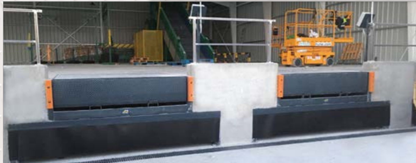
Bancada Box Model con trampilla para albergar la plataforma de los camiones.
